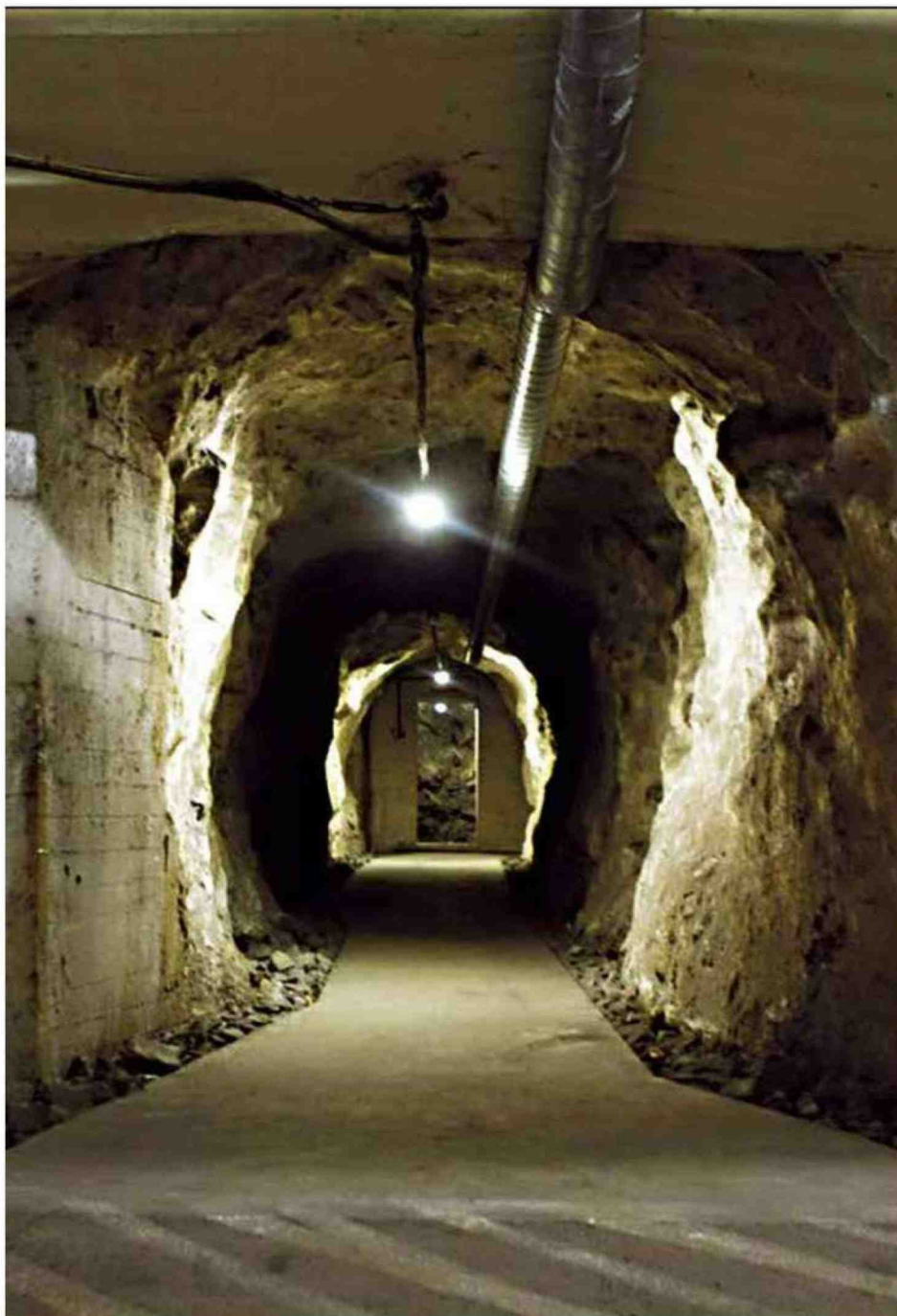
Nei sotterranei della capitale norvegese, Oslo, una serie di cunicoli costruiti durante la Guerra fredda
